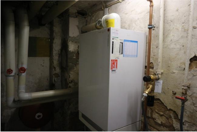
Das Pfarrhaus, in dem das Pfarrbüro als auch die Pfarrwohnung untergebracht sind, wird mit einer neueren Gasbrennwert Therme beheizt (Bild links), auch hier gibt es nur einen Gemeinsame Heizanlage. Die Warmwasserbereitung erfolgt über Einzelboiler. Zur Energieeinsparung wurde ein Hydraulischer Abgleich der Heizkörper im Jahr 2018 vorgenommen.
